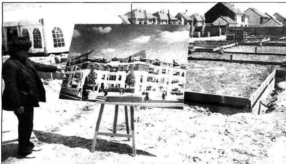
Sur ce terrain seront construits 21 maisons et 38 appartements.
