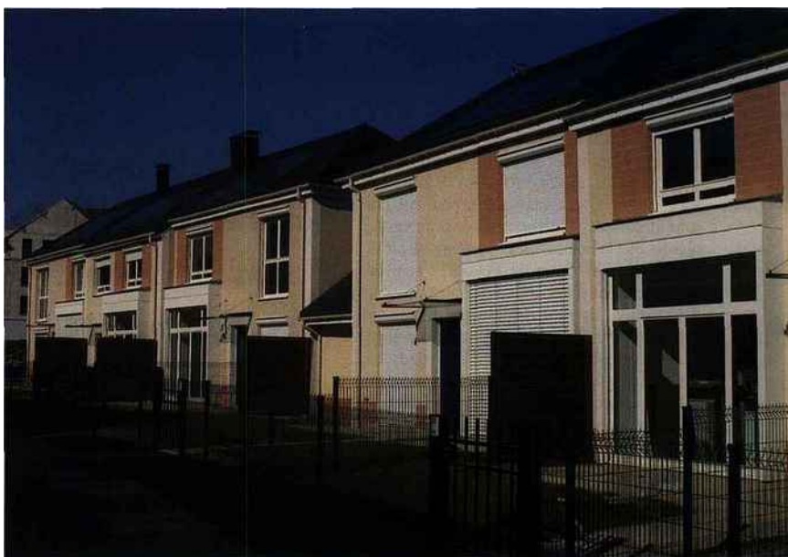
Les pavillons du programme Terra Natura à Corneilles-en-Parisis : des enveloppes isolées par l'extérieur, un système électro-solaire, une émission de chaleur par dalle active et une ventilation double flux sur puits canadien.
